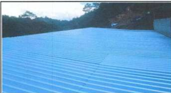
Foto 3: Entechado de lamina
