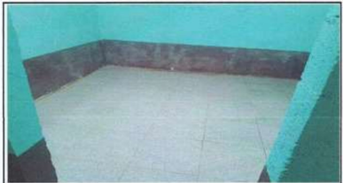
Foto 4: Instalacion de piso ceramico
