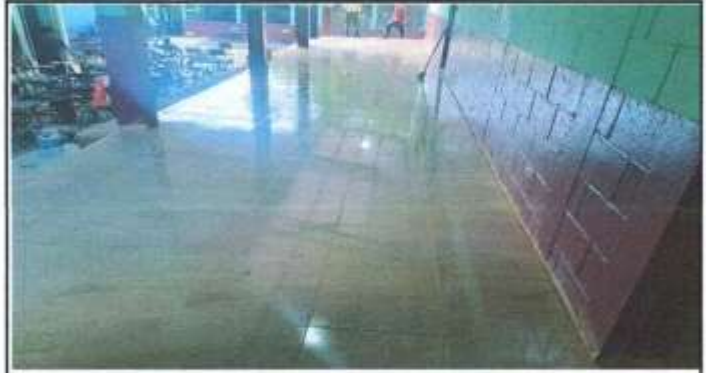
Foto 2: Instalación de piso ceramico
